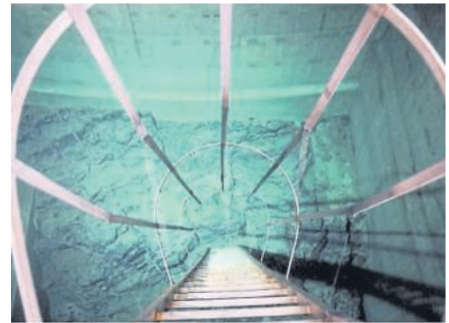
Es läuft und läuft aus der Hillenbergquelle. Trinkwasser ist ebenfalls Corona-unabhängig.
